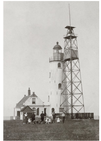
De vuurtoren in 1910. De opengewerkte toren met mistbel heeft van 1906 tot medio 1918 naast de vuurtoren gestaan.
