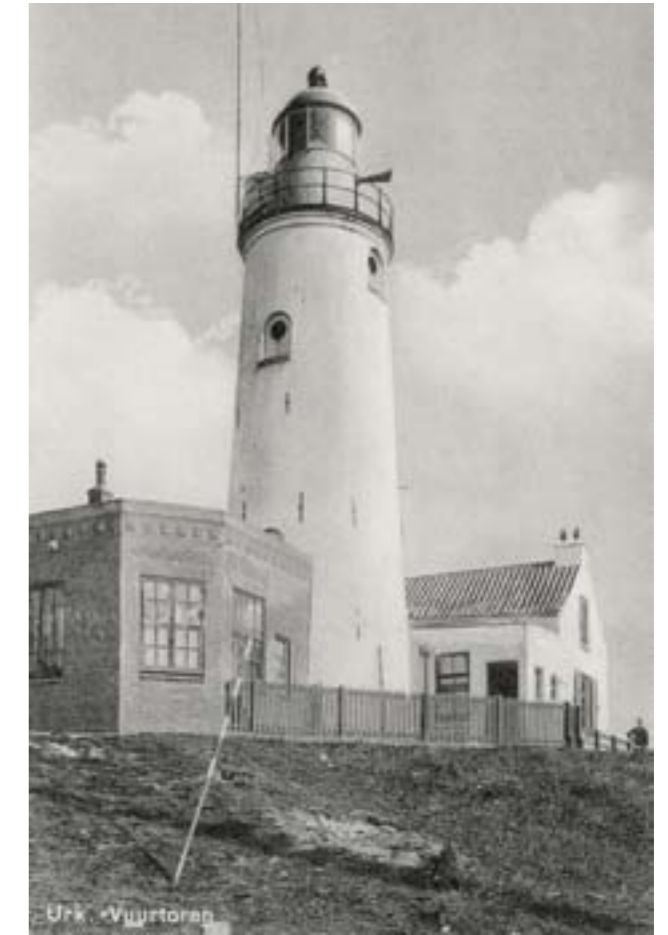
De vuurtoren in de jaren '30. De misthoorn is duidelijk zichtbaar. De perslucht hiervoor wordt geproduceerd in de machinekamer.
