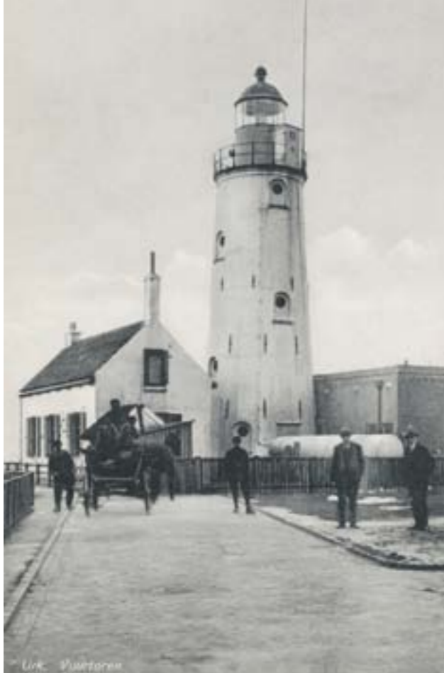
De vuurtoren eind jaren '30. De betonnen platen met patrijspoorten in de raamopeningen zijn in 1934 aangebracht.
