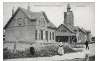
Lichtwachterswoningen, machinegebouw en de vuurtoren in 1907.
