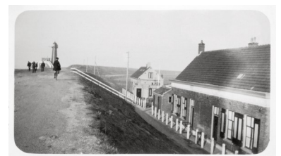
De witte lichtwachterswoning uit 1875 en de dubbele lichtwachterswoning uit 1886, aan de voet van de Westkapelse Zeedijk in 1933.
