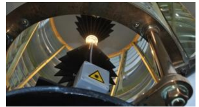
De in 2018 geplaatste ledlamp.
