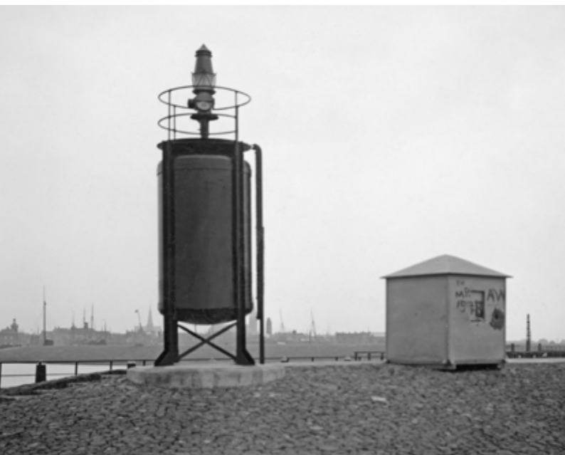
Het in 1912 geplaatste lage licht op de Zuiderhavendam.
