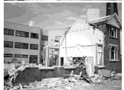
Afbraak van het proefstation en nieuwbouw voor het Loodswezen in 1977.
