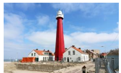
Vuurtoren en lichtwachterswoningen in april 2021. Het gebouw van het Loodswezen ernaast is geheel gesloopt. De bouw van het appartementencomplex moet nog beginnen.
