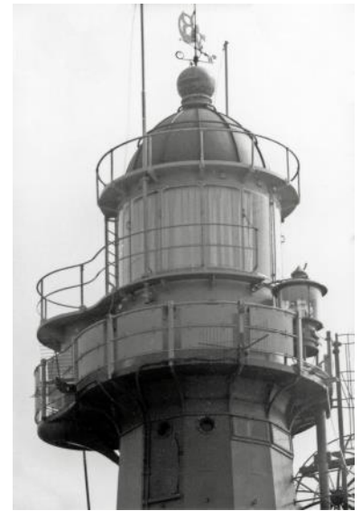
De kop van de vuurtoren in 1960. Op de omloop is een hulplicht geplaatst.
