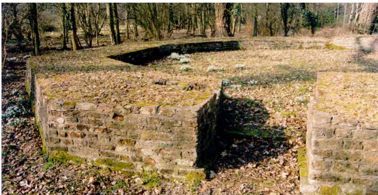
Het fundament van de Stenen Kaap aan de Zwartelaan in Oostvoorne kreeg in 1971 de status van rijksmonument.
