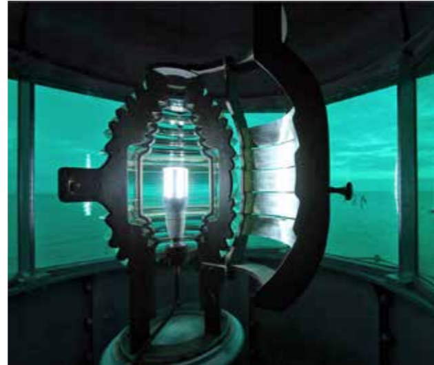
De beide havenlichten hebben nog steeds hun oorspronkelijke door Chance Brothers uit Birmingham geleverde optiek.
