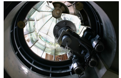
De optiek van de Maasvlakte van onderaf gezien, met zicht op de aandrijfmotor en de lampenwisselaar. Deze zijn inmiddels verdwenen, alleen de optiek is er nog.
