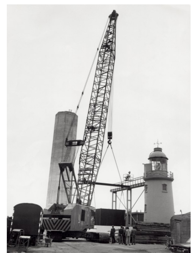
Tegelijkertijd met de bouw van de vuurtoren op de Maasvlakte werden de twee torens van de rode lichtenlijn gebouwd op de noordelijke oever van de Nieuwe Waterweg. De beide foto's tonen de bouw van het lage licht.
