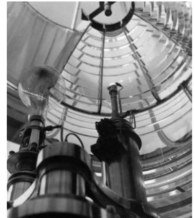
De oorspronkelijke lampenwisselaar uit 1923, met gloeilamp en gasgloeilicht.
