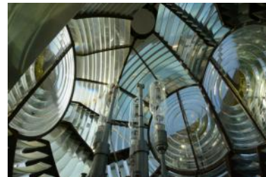
De optiek van 1950, met een moderne lampenwisselaar met kwikjodidelampen.
