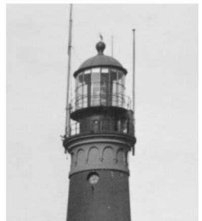
De in 1907 geplaatste lantaarn en lantaarnkuip.
