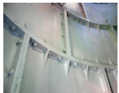
De schacht is opgebouwd uit gebogen gietijzeren platen met opstaande randen die met bouten aan elkaar zijn bevestigd.
