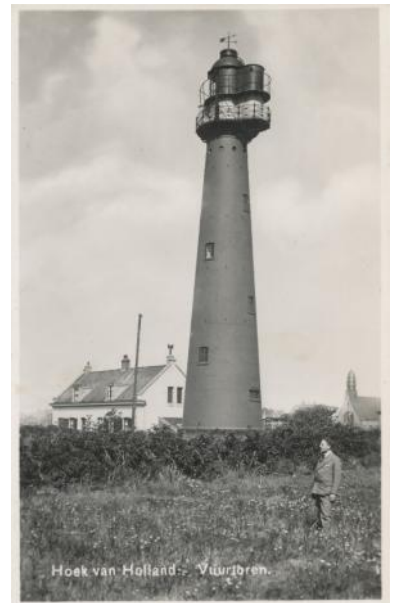
Het hoge licht omstreeks 1934. De karakteristieke uitbouw van het lichthuis en de omloop is in 1912 aangebracht.
