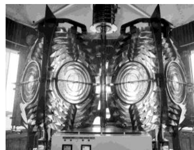
De dubbeloptiek van het hoge licht uit 1909.
