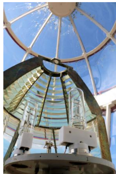
De lampenwisselaar uit 1981 met halogeenlampen.
