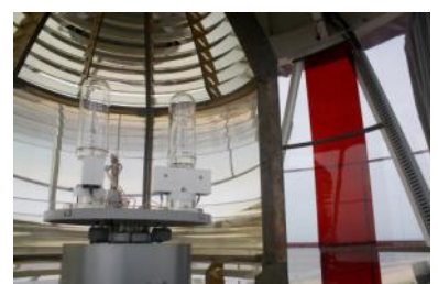
De huidige optiek met een lampenwiel met halogeenlampen.
