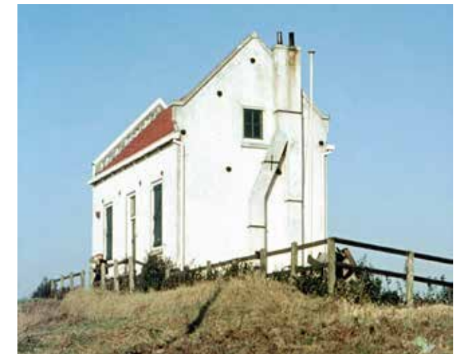
De lichtwachterswoning ca.1960. Deze werd in 1964 afgebroken.
