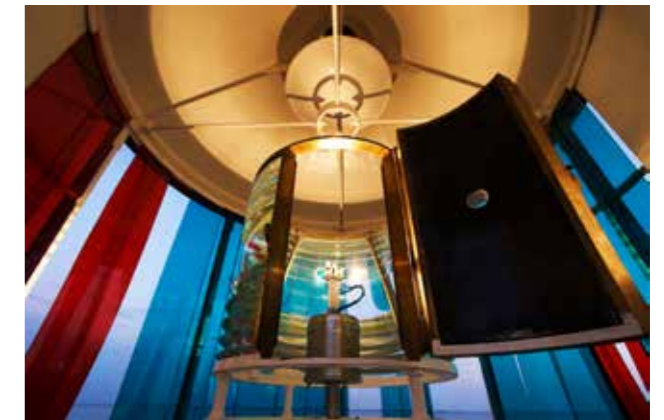
Het interieur van het lighthouse in 2013, vlak voordat de trommeloptiek en de rode en groene sectoren werden verwijderd.
