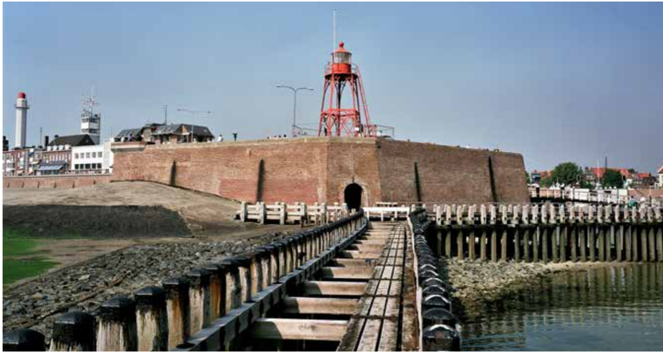
Het Keizersbolwerk in 1989. Het havenlicht heeft nog het originele onderstel uit 1876. Er zijn hekken omheen gezet ter voorbereiding van de demontage. Helemaal links de nieuwe radartoren van de Schelderadarketen. Daarnaast de Nederlandse loodsensociëteit met de opbouw met twee uitkijkklokken. Het witte gebouw is de Belgische loodsensociëteit. Het hotel Noordzee Boulevard is er niet meer.
