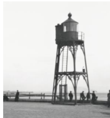
Het havenlicht in 1913. De kleine lanthuis werd in 1907 vervangen door een groter lichthuis met tochtportaal.
