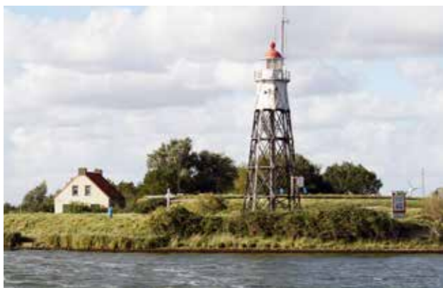
De in slechte staat verkerende vuurtoren in 2012.
