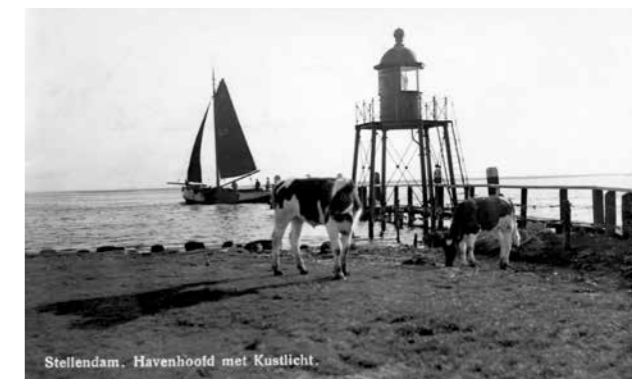
Het havenlicht met de oorspronkelijke koepel met walmbol.
