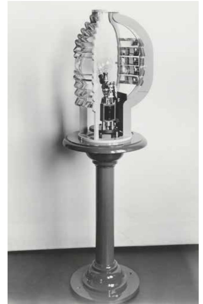
De optiek van Zoutelande die afkomstig is uit de ijzeren opstand, in een proefopstelling bij de Technische Dienst van de Kustverlichting in Scheveningen, vermoedelijk in 1951. Deze optiek heeft nog ongeveer een jaar dienst gedaan in de nieuwe stenen lichtopstand en is daarna vervangen.
