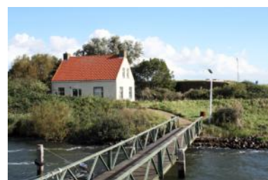
De voormalige lichtwachterswoning en de aanlegsteiger voor de bootverbinding met het vasteland in 2012.
