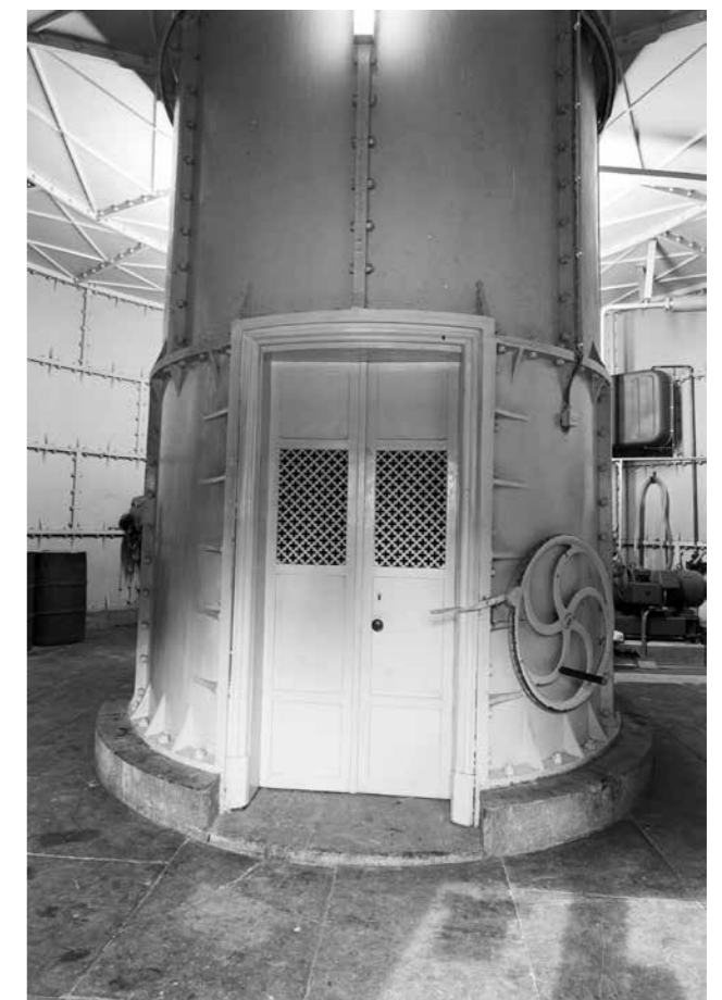
De gietijzeren binnenschacht in 1976.
