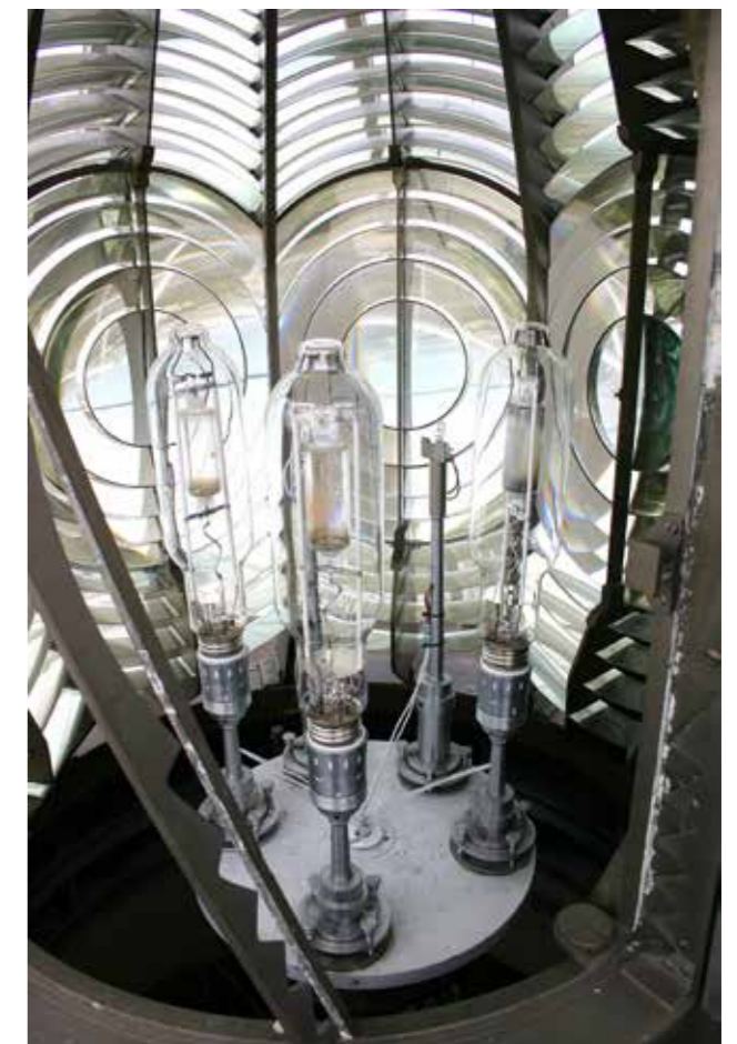
De optiek van de Maasvlakte in 2004, met kwikjodidelampen.
