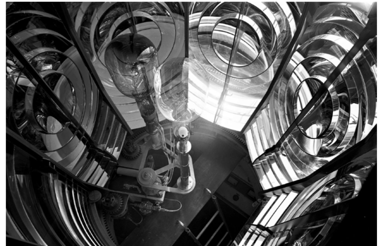
De optiek van het hoge licht van Hoek van Holland in 1973, met een lampenwisselaar met twee cilindrische Brandarislampen.
