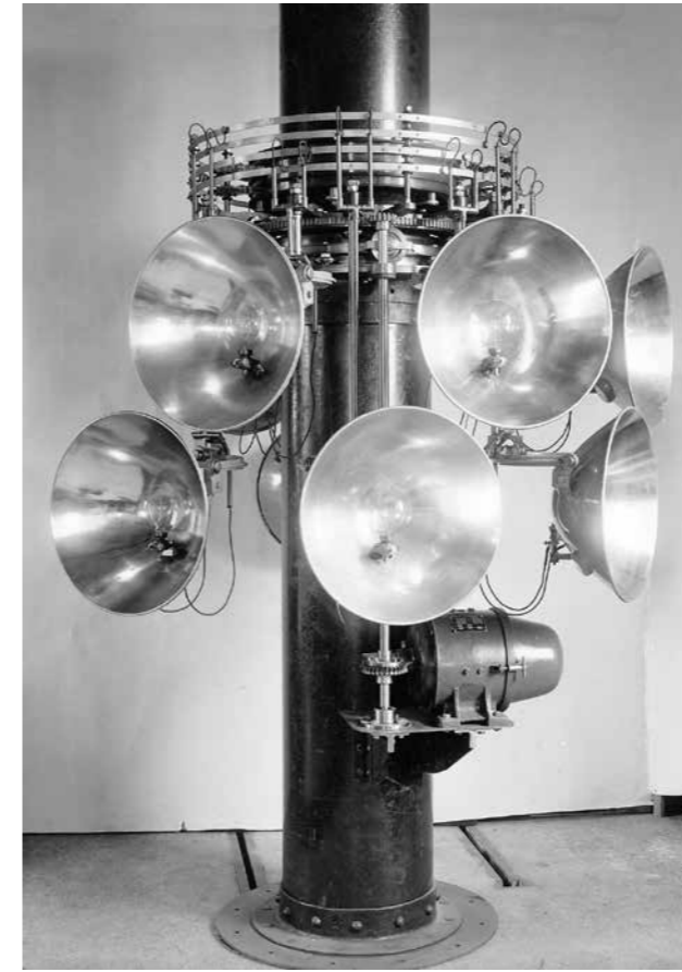
Lichttoestel van een lichtschip, met reflectoren met halfwattlampen van 550 watt (110 V-5 A), in de jaren twintig.
