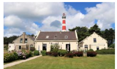
De voormalige lichtwachterswoningen zijn deels particulier bezit en deels eigendom van de gemeente. Ze worden verhuurd voor toeristisch verblijf.
