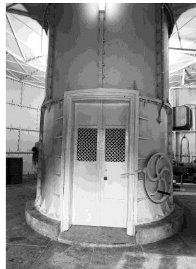
De binnenschacht van de toren in 1976.
