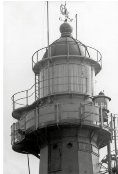
De kop van de vuurtoren in 1960. Op de omloop is een hulplicht geplaatst.
