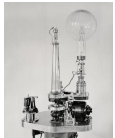
De lampenwisselaar voor Kijkduin in het proefstation te Scheveningen in 1924.
