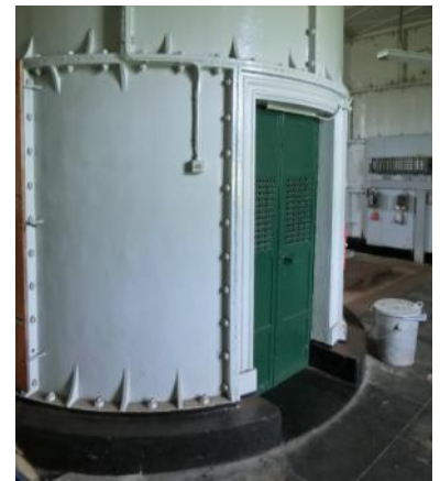
Het interieur van de Lange Jaap. De buitenschacht is hoekig, de binnenschacht rond.
