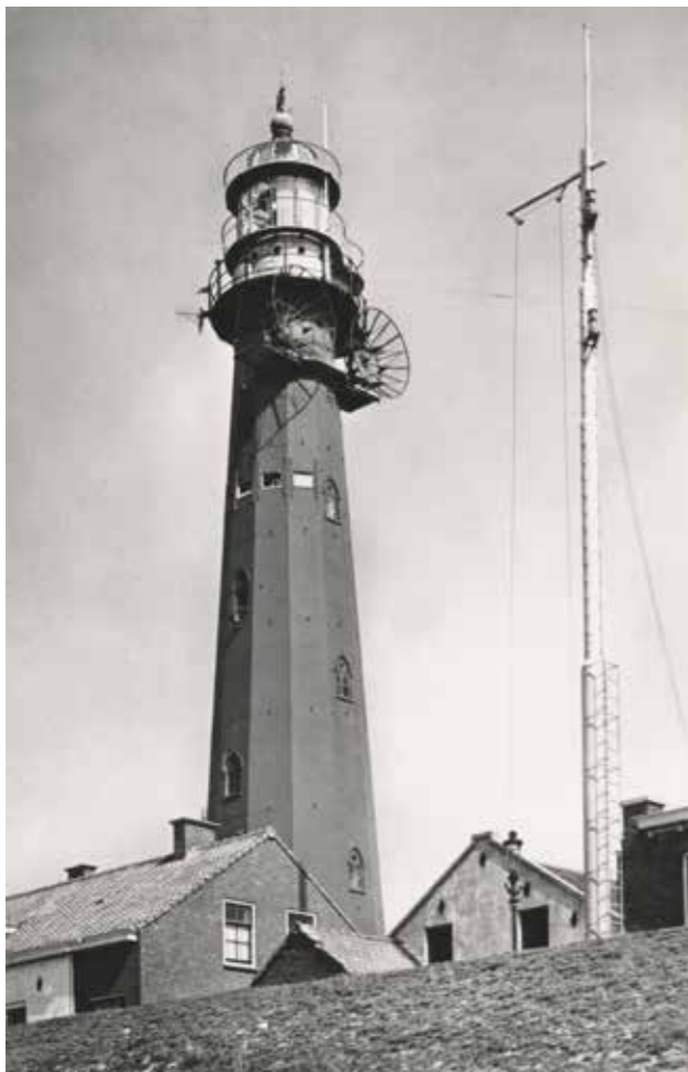
De vuurtoren in 1959, met de in 1936 geplaatste stalen seinmast.
