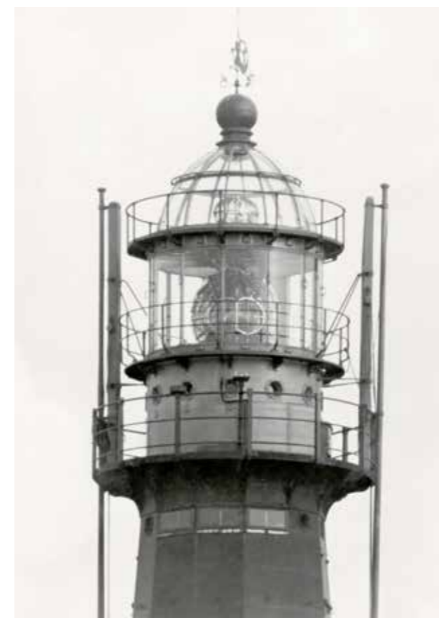
In 1922 kreeg de vuurtoren een nieuwe scheepvaartoptiek, een luchtvaartoptiek en een glazen koepel met een extra omloop.
