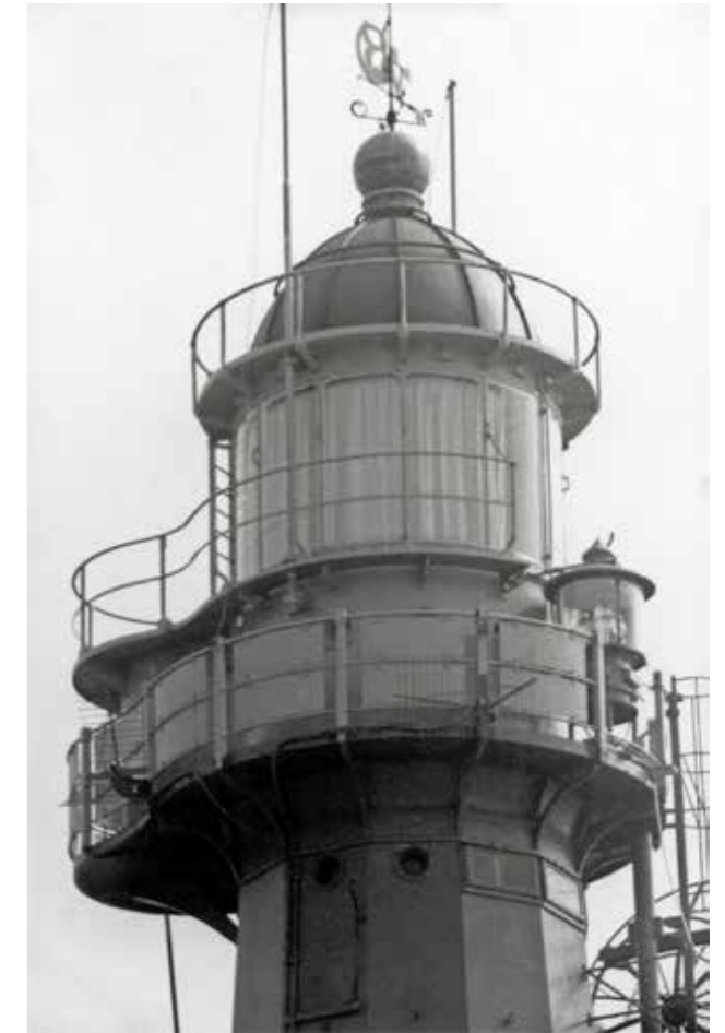
De kop van de vuurtoren in 1960. Er is een hulplicht geplaatst op de eerste omloop, omdat er voorbereidingen worden getroffen om het kwikbad van de optiek te verwijderen en de optiek over te zetten op een kogellager met elektromotor. De bovenste omloop zal worden verwijderd en de ramen onder de onderste omloop zullen verdwijnen omdat er nieuwe gietijzeren platen worden aangebracht.
