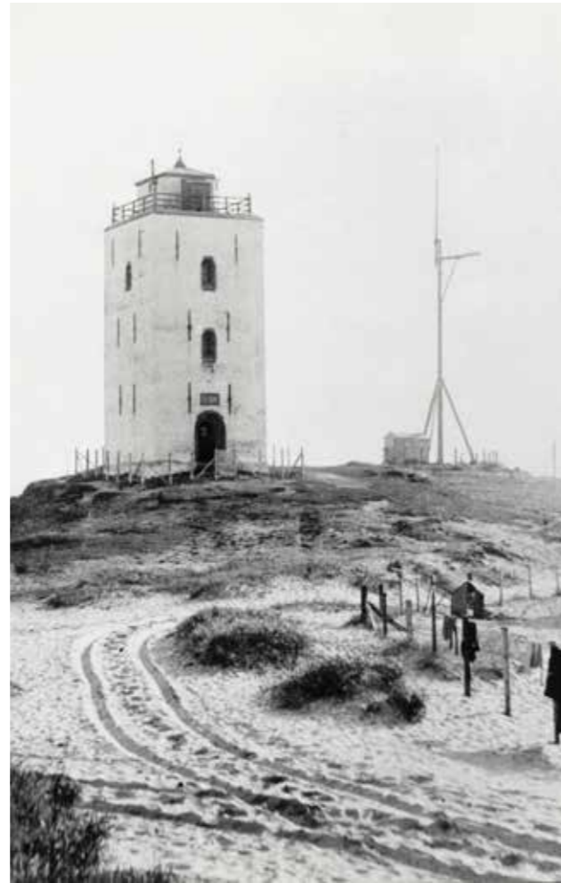
De vuurbaak vlak na de restauratie van 1901, waarbij er een nieuwe mantel om de toren is gebouwd.
