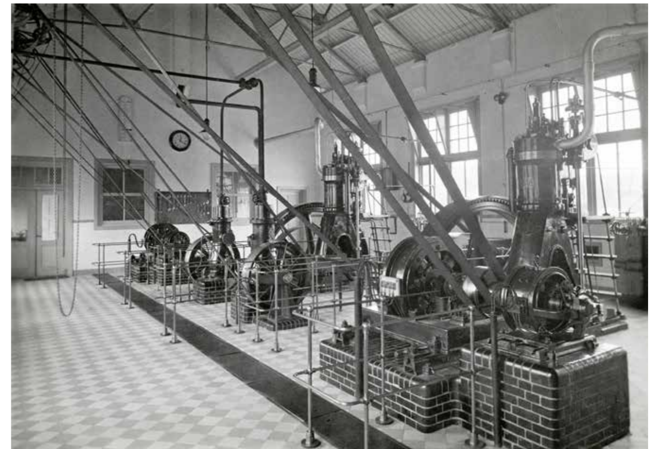
Het interieur van de nieuwe machinekamer, met daarin de dynamo's voor het opwekken van elektriciteit.
