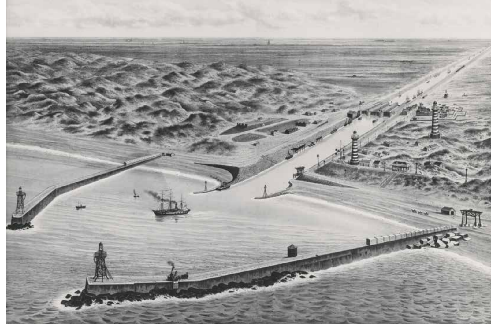
Het Noordzeekanaal in 1880 op een tekening uit het archief van Hoogovens (nu Tata Steel Nederland). Op de havenhoofden twee gietijzeren havenlichten. Op de kribben houten lichtopstanden en in het duingebied de nieuwe gietijzeren vuurtorens.
