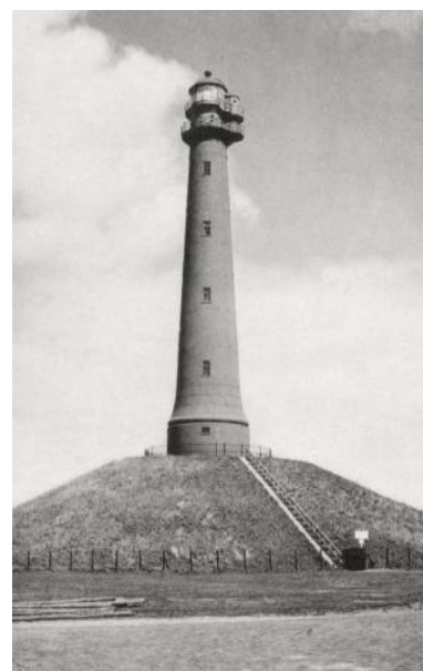
Het hoge licht in 1953. De in 1908 aangebracht uitbouw van de lantaarn en de lantaarnkuip is hierop goed te zien.
