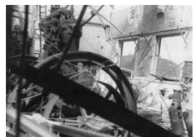
De in 1943 gebombardeerde machinekamer.
