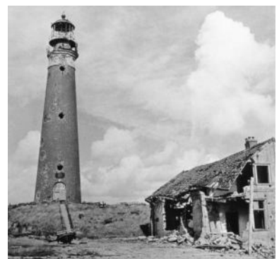
Na de opstand der Georgiërs bleef de vuurtoren zwaar beschadigd achter. De lichtwachterswoningen lagen volledig in puin.
