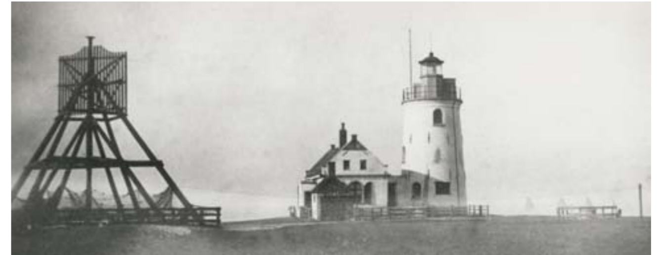
De vuurtoren in 1900. Een jaar later is de gemetselde torenschacht met ruim vijf meter verhoogd en is er een nieuw lichthuis geplaatst. De kaap is in 1923 afgebroken.
