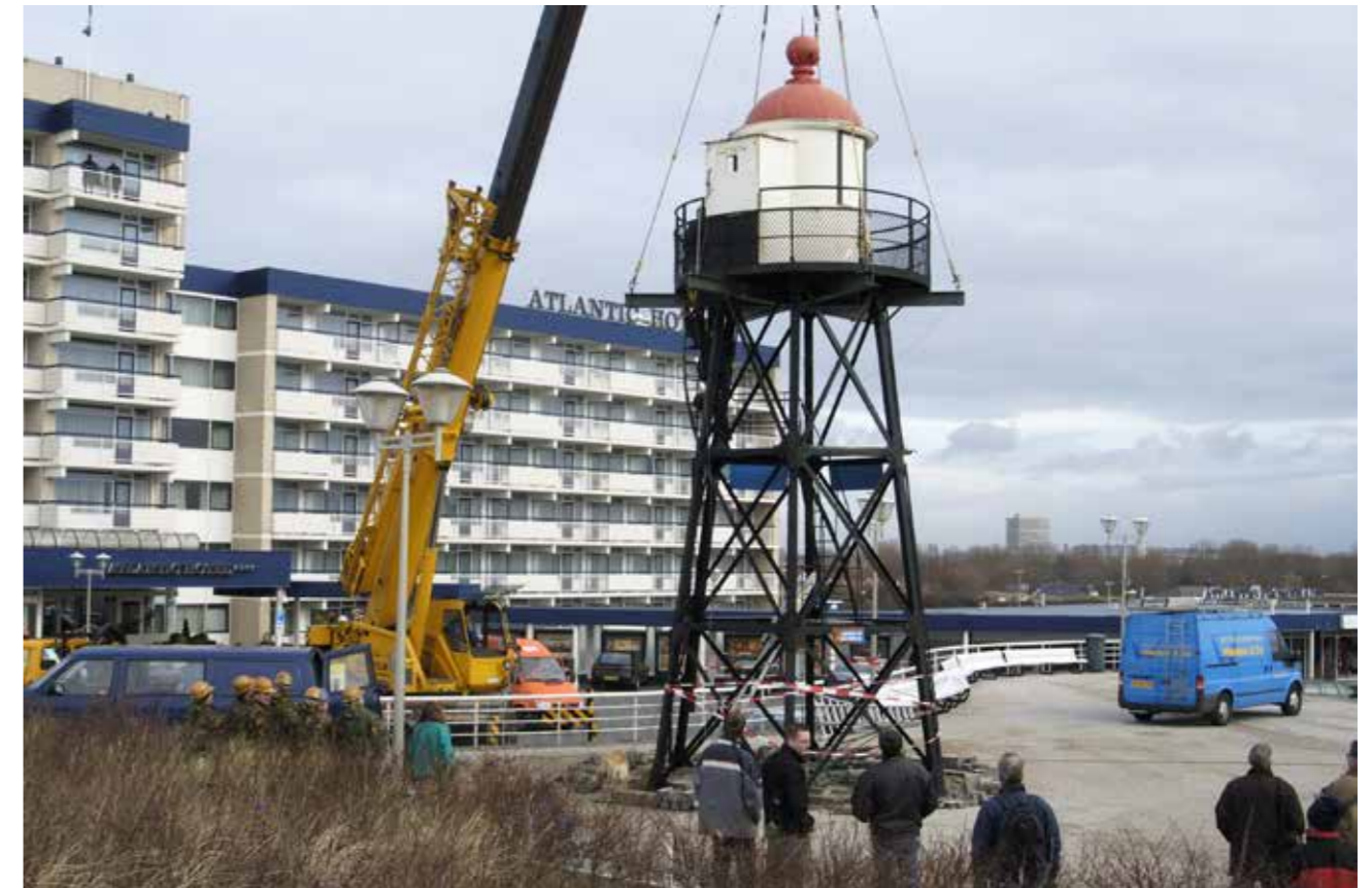
Het hoge licht op het Deltaplein in Kijkduin op 9 februari 2004. Op deze dag heeft Defensie tests gedaan om te beoordelen of de constructie van het vuurtorentje bestand zou zijn tegen het luchttransport.
