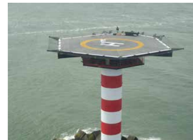
Helikopterplatform van het noordelijke havenlicht.
