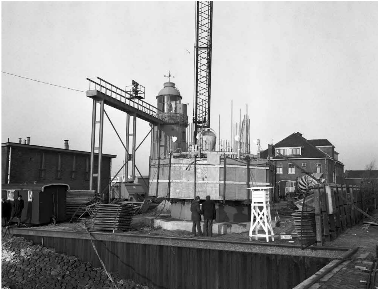
Begin van de bouw van het lage licht Nieuwe Waterweg, 29 November 1973. Geen prefabelementen maar betonstort met glijbekisting.
