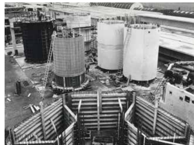
Prefabelementen voor de havenlichten in opbouw op het werkerrein in Katseveer, 5 april 1973.
