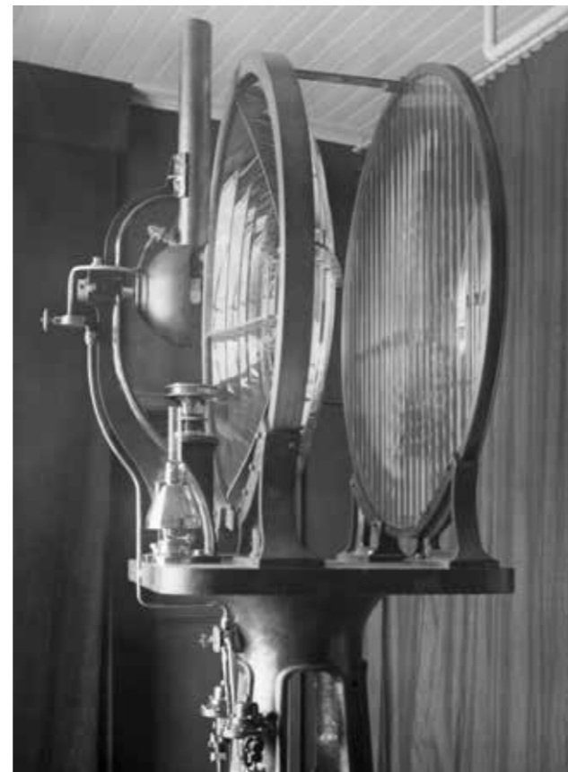
De optiek met bundellens en spreidingslens die in 1913 in het lage licht in gebruik is genomen.
