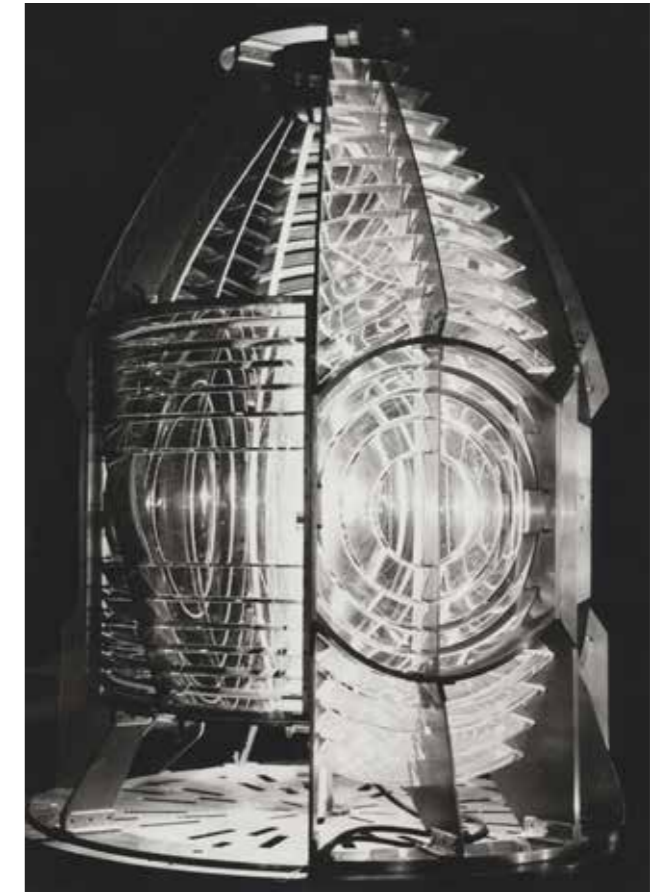
De optiek van het hoge licht uit 1960.
