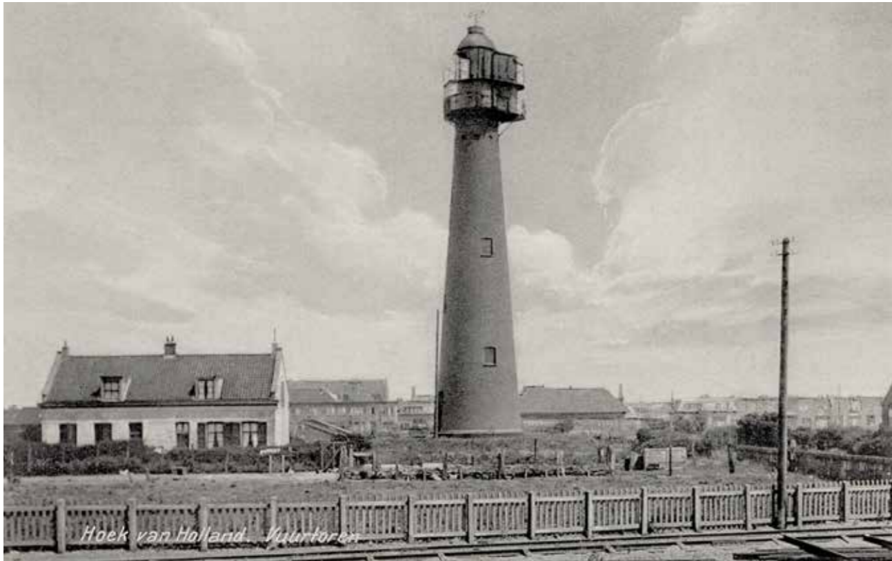
Het hoge licht in 1935. De uitbouw bij de lantaarn en het bovenste segment van de toren is in 1912 aangebracht, met het oog op het plaatsen van de installatie voor een bliksemlicht.
