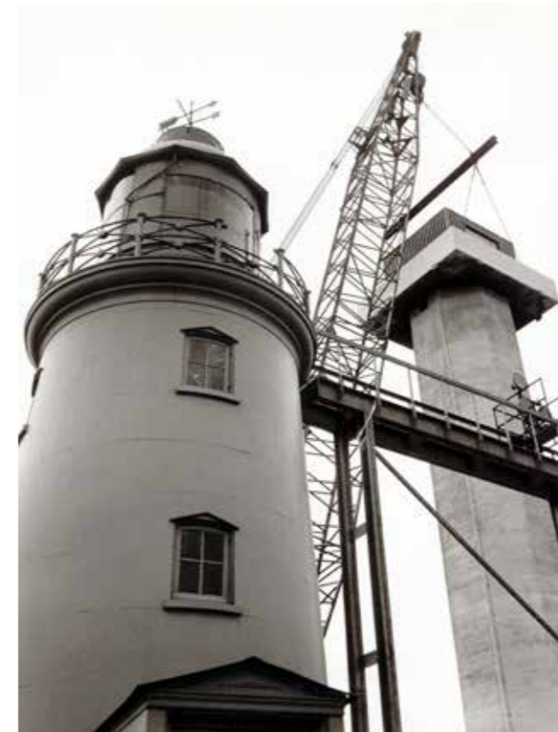
Het nieuwe lage licht in aanbouw: 13 mei 1974.
