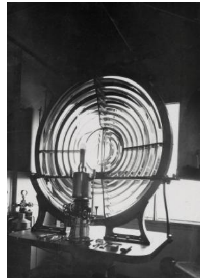
De optiek van de Kleine Kaap, met pharolinegloeilicht.
