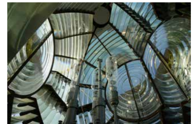
De huidige optiek en lampverwisselaar met kwikjodidelampen.
