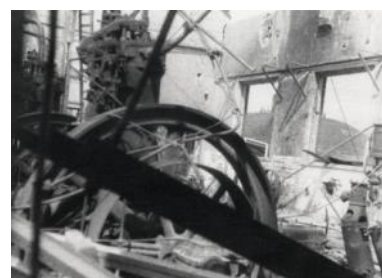
Het in 1943 gebombardeerde machine- gebouw.
