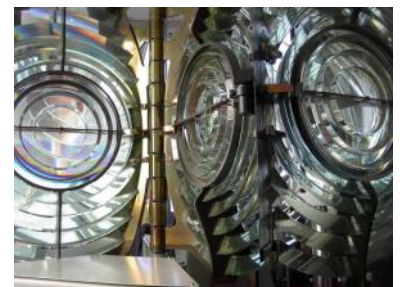
De dubbeloptiek van het hoge licht.
