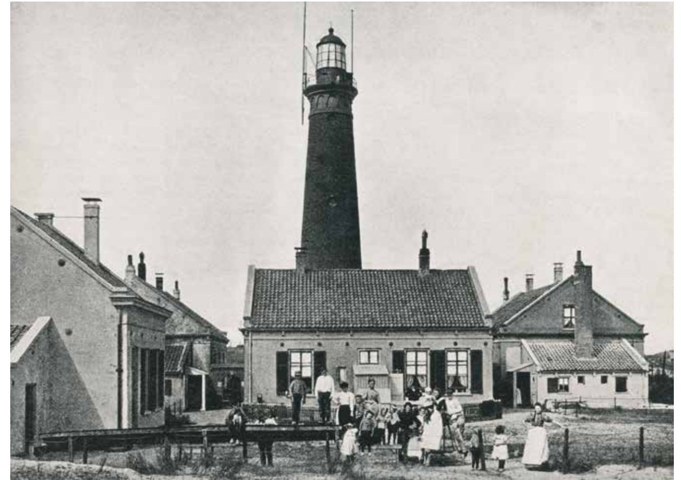
Het vuurtorencomplex met vier lichtwachterswoningen omstreeks 1900. De lantaarn heeft nog zijn oorspronkelijke verschijningsvorm.
