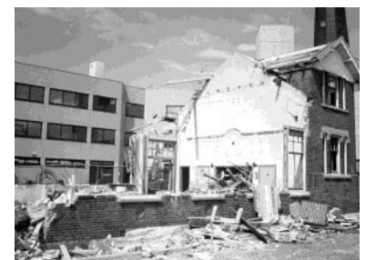
Afbraak van het proefstation en nieuwbouw van het Loodswezen in 1977.
