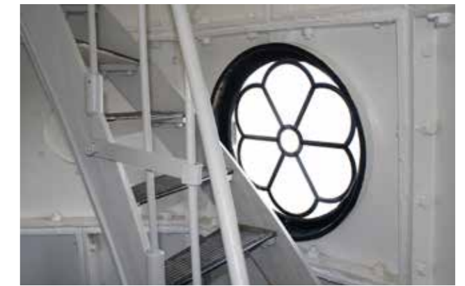
Renovatie van het interieur, 19 september 2014, en het opgeknapte interieur in 2015.
