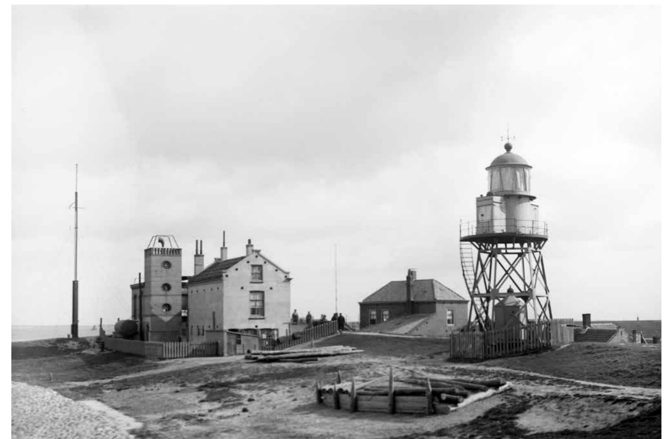
De Nieuwe Sluis omstreeks 1913. Links het vergrote misthoorngebouw en de woning van de machinist. Rechts het lage licht met een extra lichthuis op de omloop, om een versterkte sector langs de lichtenlijn te creëren.
