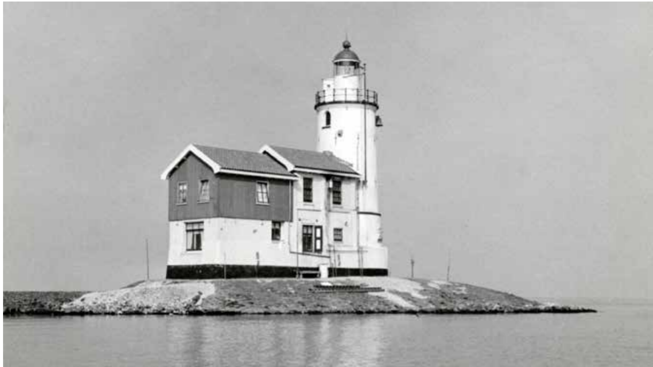
De vuurtoren in 1961, vlak na het gereedkomen van de verbouwing, waarbij de woning is vergroot met een houten opbouw en er flauw hellende pannendaken zijn aangebracht.
