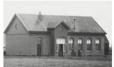
Het machinegebouw aan de Grindweg, thans Casembrootstraat, in 1907.
