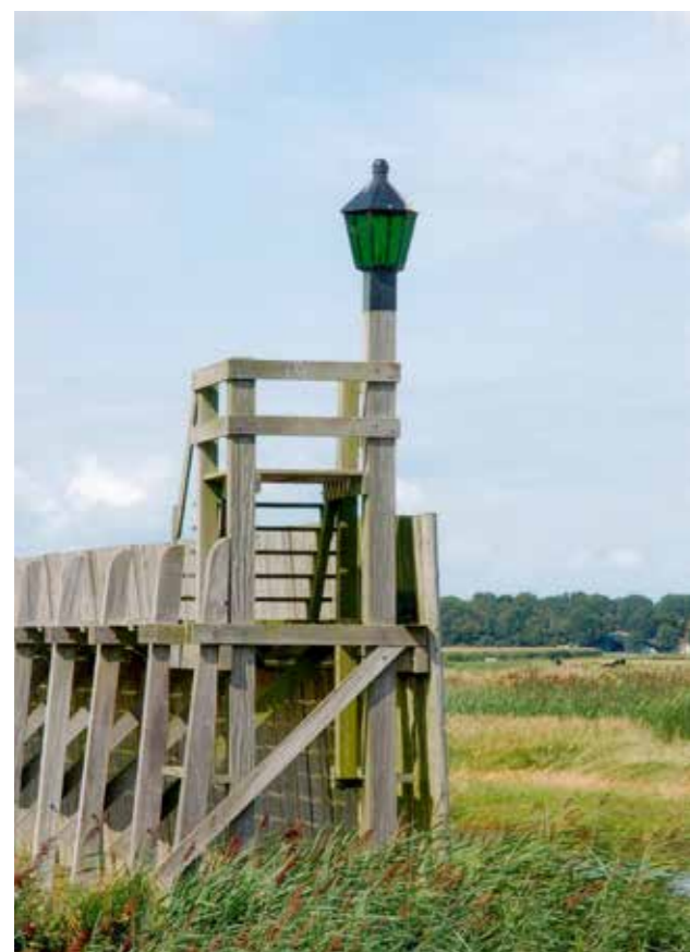
Het gereconstrueerde havenhoofd met het groene havenlicht.
