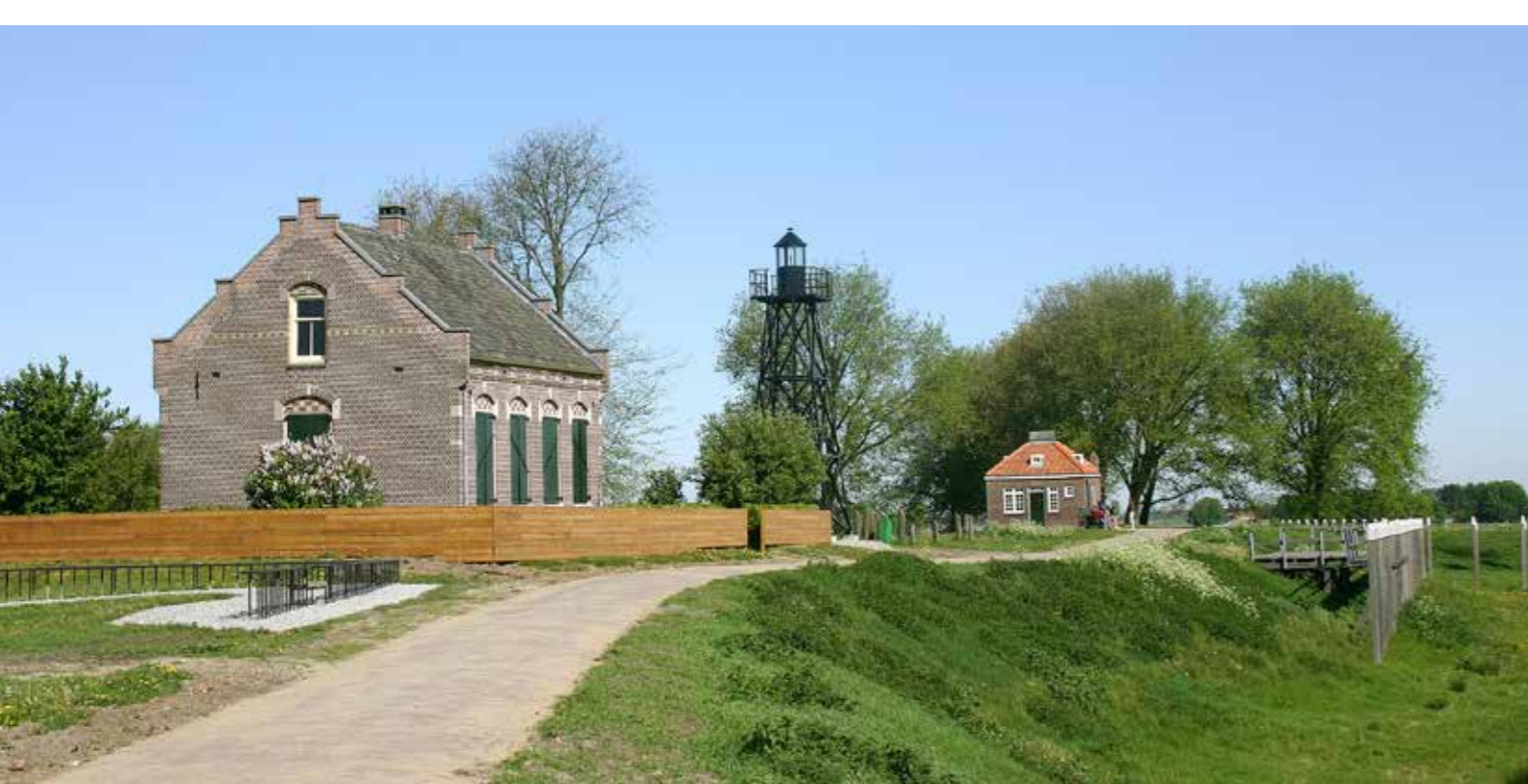
Emmeloord in 2007, met links de lichtwachterswoning, daarnaast de replica van de vuurtoren en daarachter het misthoorngebouwtje. Wat nu een laaggelegen grasland is, was vroeger de haven. De havenhoofden en de aanlegsteiger zijn gereconstrueerd.
