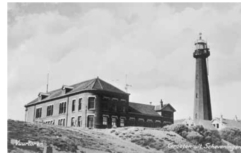
Het proefstation na de verbouwing van 1920 waarbij aan de zuidzijde het dak van het middengedeelte is verhoogd en er een verdieping bij is gekomen.
