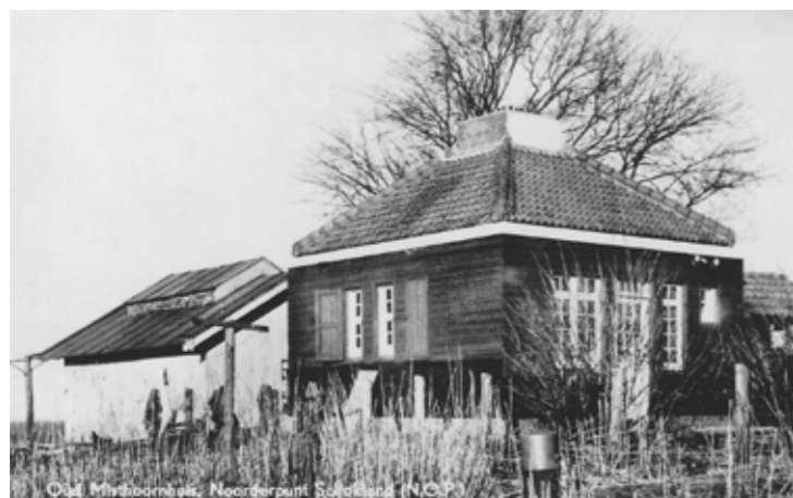
Het misthoorngebouw is vlak na de Tweede Wereldoorlog geschikt gemaakt als woning en bekleed met houten planken.
